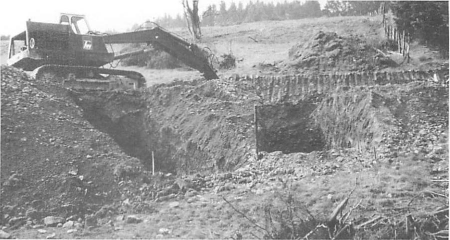
Abb. 1. Baubeginn für den künstlichen Fledermausstollen. Ein Bagger hebt die Baugrube aus. Aufn.: C. BUCHEN, 4. IV. 1991
