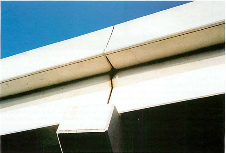
Abb. 5. Der Ausflug der Fledermäuse erfolgte aus den seitlichen Spalten der Brückenträger. Aufn.: V. GIESE
