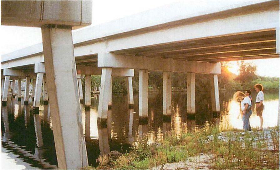
Abb. 7. Unterhalb der US-41 entschwanden aus fast alle Spalten Fledermäuse. Der Geruch war weniger intensiv, da die Fäkalien direkt in den darunter fließenden Myakka-River herabfallen konnten. Aufn.: H. SCHWARTING
