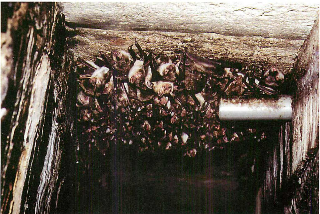
Abb. 1. Wochenstübedes Mausohrs ( Myotis myotis ) in der Imbrücke der Bundesautobahn A4 Eisenach - Dresden bei Mellingen. Die ca. 250 Tiere hängen in einem engen Entwässerungskanal. Aufn.: DR. ALFRED NAGEL
