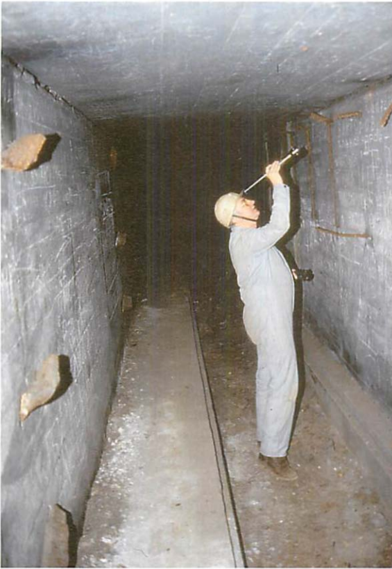
Abb. 7. Versorgungsgang, der in der Tiefe alle Häuser der Maybach-Anlage I miteinander verbindet, aber durch massive Sprengeneinwirkung an zahlreichen Stellen unpassierbar wurde. Die Schwierigkeit der Absuche bestand darin, daß durch die Sprengungen tiefe, mit lockerem Material angefüllte Zerklüftungen zwischen Wand und Decke entstanden. Beachte die vielen russischen Inschriften. Aufn.: R. BAUER/Rangsdorf
