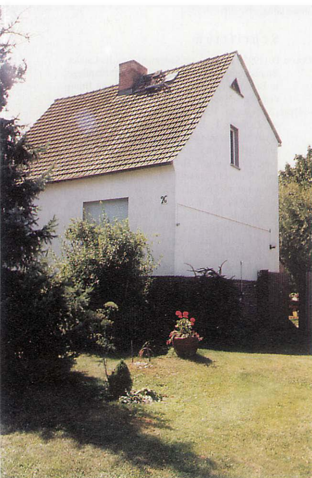
Abb. 1. An der im Foto dargestellten Ostseite befindet sich hinter der rechten unteren Dachhälfte das Wochenstubenquartier von Vespertilio murinus . Aufn.: J. TEUBNER
