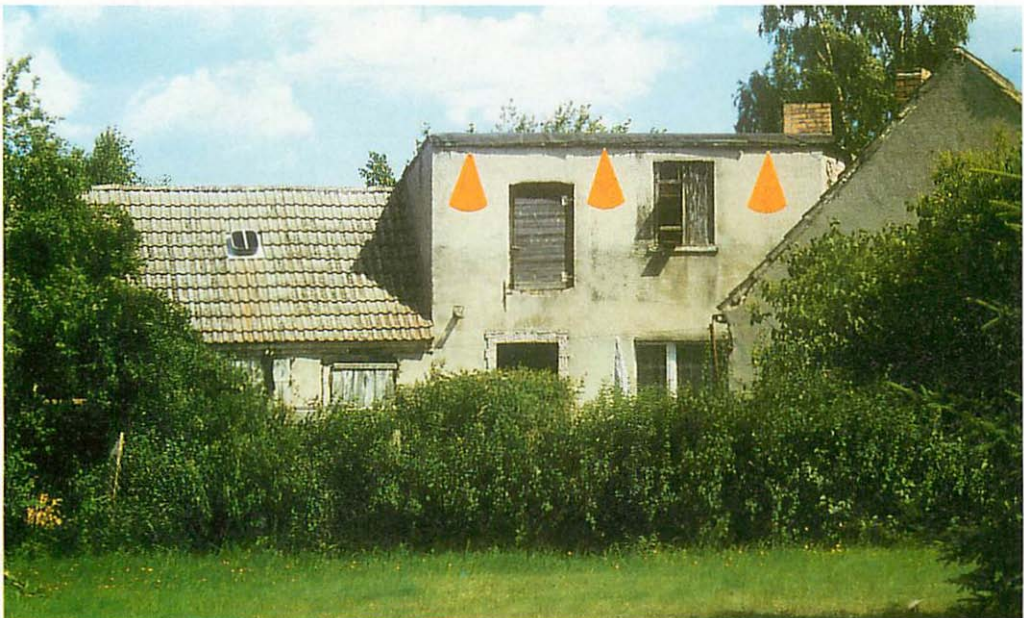
Abb. 12. Gebäudeeinheit Ende 6 mit Stall und Taubenschlag, rechts ist das Wohnhaus erkennbar. Die Pfeile weisen auf die Ein- und Ausflüge zum Sommerquartier von V. murinus . Aufn.: U. HERMANN'S
