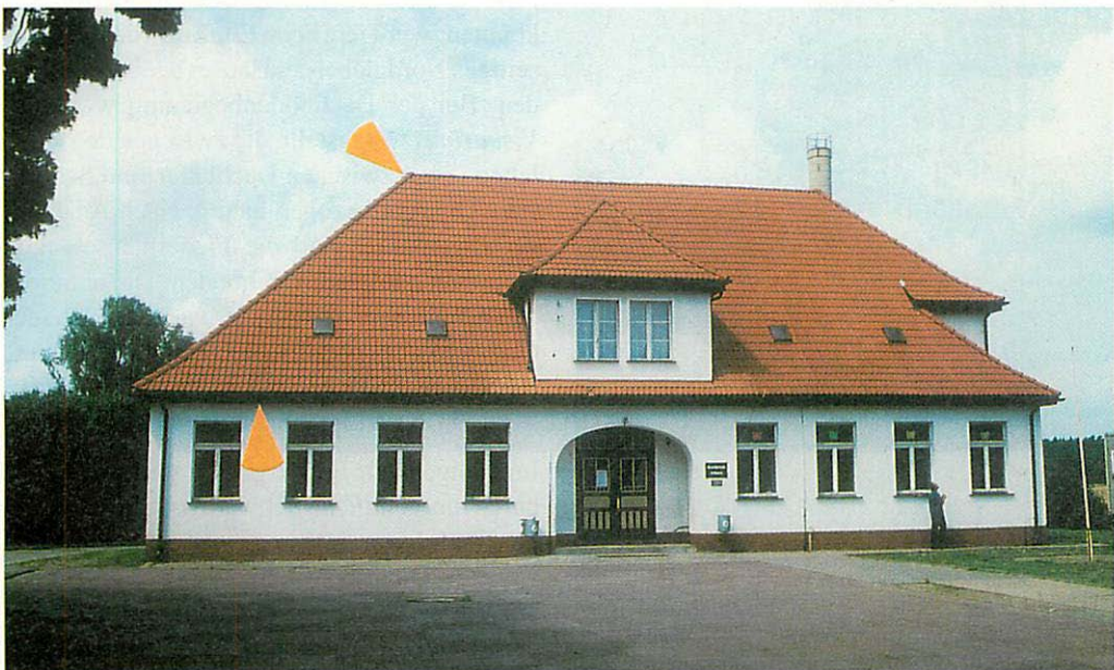
Abb. 9. Schulgebäude I. Der Ausflug von Vespertilio murinus befindet sich unter der westlichen Firstkappe (Pfeil). Ein weiterer Quartierort ist unter der Dachrinne zu finden (Pfeil). Aufn.: U. HERMANN'S
