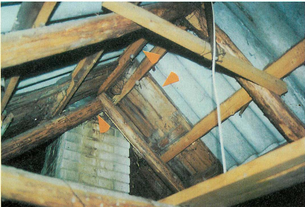
Abb. 20. Dachboden Wohnhaus Budy Nr. 32 – die Pfeile weisen auf drei Quartierstandorte von V. murinus : zwischen Schornstein und Holzlatten, zwischen Verbretterung und Dachplatten und zwischen Dachfirstlatten. Aufn.: U. HERMANN'S
