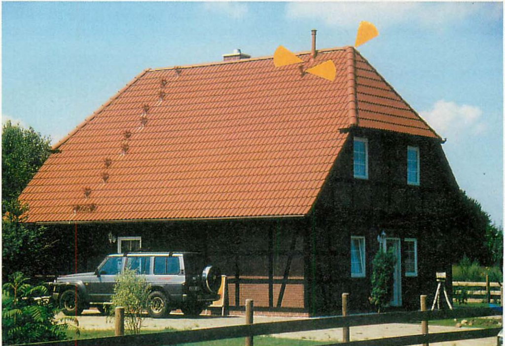
Abb. 13. Eigenheimneubau Gegensee 61. Die Besiedlung durch Vespertilio murinus erfolgte bereits zwei Jahre nach der Fertigstellung des Gebäudes. Die Pfeile weisen auf die festgestellten Einflüge zum Sommerquartier. Aufn.: U. HERMANNs
