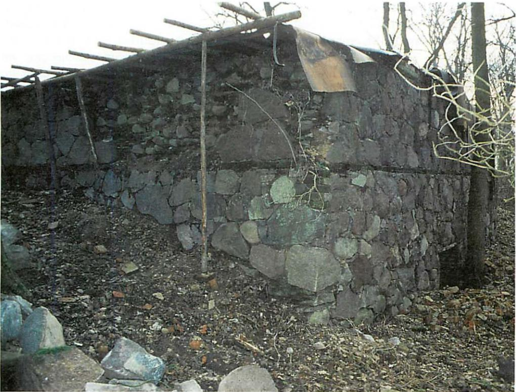
Abb. 2. An den Hang gesetzter Eiskeller nach ersten Sicherungsmaßnahmen, von der Rückseite betrachtet; rechts erkennt man den unteren/hinteren Eingang. Aufn.: U. GRÜTZMACHER
