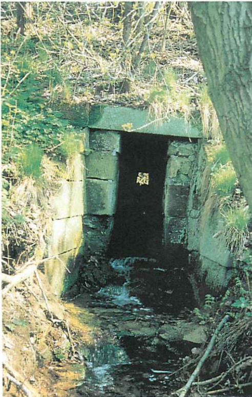
Abb. 4. Dieser kleine Durchlaß (Wd 14) leitet das Wassereines Teiches durch den Bahndamm und ist Winterquartier für das Braune Langohr und die Fransenfledermaus. Aufn.: G. HÜBNER
