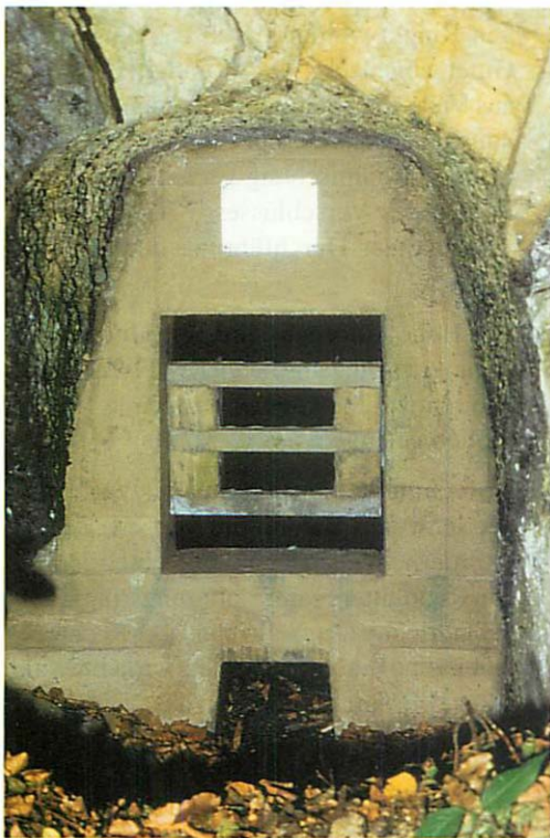
Abb. 6. Verschluss der Eisenerzgrube „Eleonore“ in einem Ortsteil von Greifenstein. Aufn.: OTTO SCHÄFER
