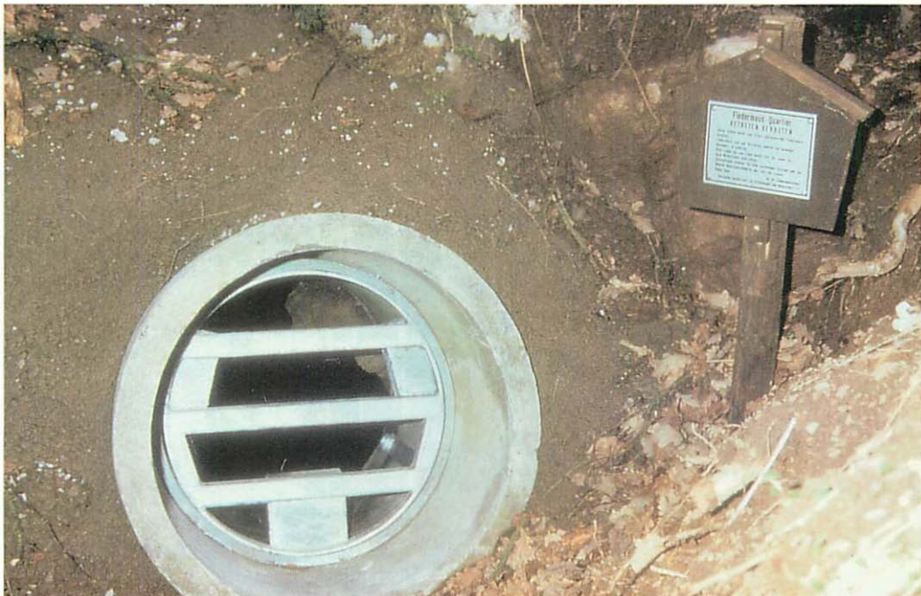
Abb. 9. Verschluss der Rotschiefergrube „Franz“ in einem Ortsteil von Häiger. Aufn.: ROLAND HEUSER
