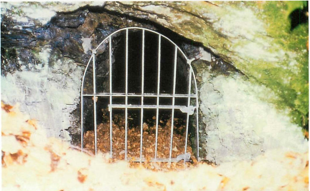
Abb. 10. Verschluß der Dachschiefergrube „Morgenstern“ in einem Ortsteil von Brechen. Aufn.: JOSEF KOETTITZ
