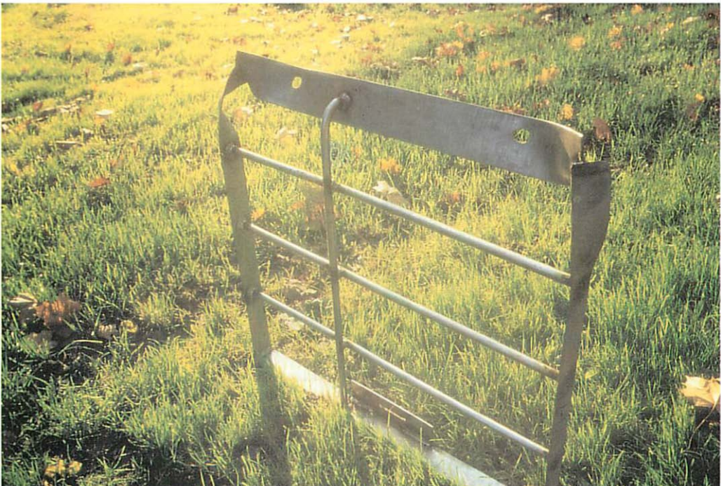
Abb. 18. Einfachgitter mit durch einen Aufbruch entstandenen, irreparablen Schaden. Aufn.: RUDOLF FIEBEL.
