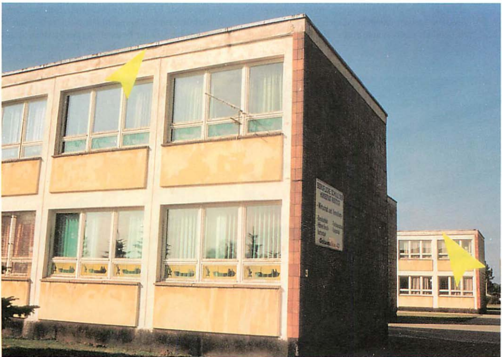
Abb. 6. Ostseeallee 43 Schulkomplex. Die Markierungen weisen auf zwei der sechs Drenpelquartiere der Zwergfledermaus ( Pipistrellus pipistrellus ) an der Südseite der Schulgebäude. Aufn.: H. POMMERANZ
