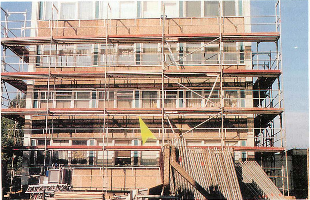
Abb. 4. Helsinki Str. 83. Die Markierung weist auf ein Wochenstubenquartier der Zwergfledermaus ( Pipistrellus pipistrellus ) unter dem Fensterbrett am Südgiebel des Gebäudes. Aufn.: H. POMMERANZ
