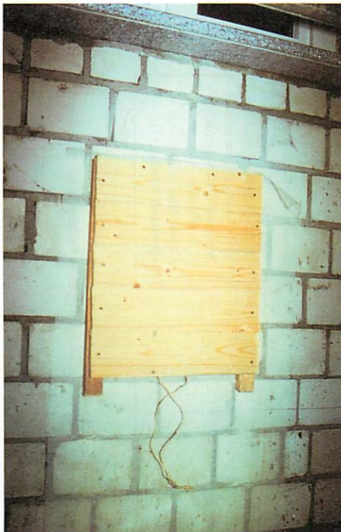
Abb. 21. II. Schritt. Aufschrauben der Deckbretter. Aufn.: U. HERMANN
