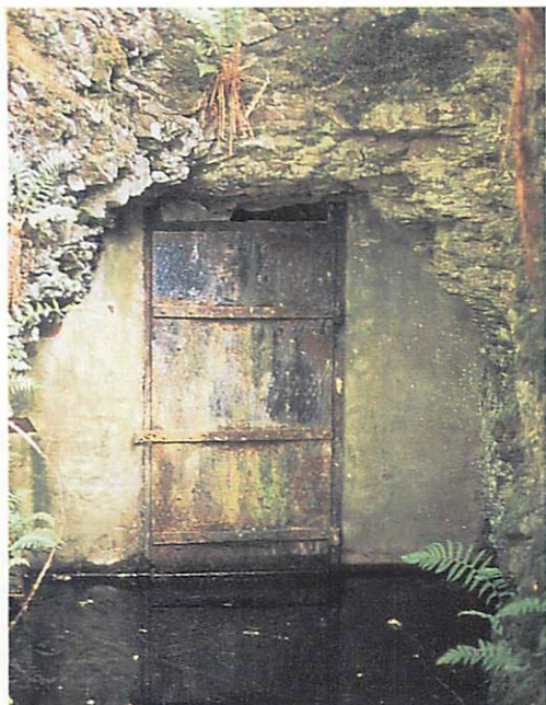
Abb. 4. Sicherung eines ehemaligen Bergwerkstollens bei Morsbach mit einer Blechtür. Über der Tür wurde nachträglich ein Einflugschlitz für die Fledermäuse geschaffen, wodurch der Stollen seither regelmäßig zum Überwintern aufgesucht wird. Aufn.: C. BUCHEN
