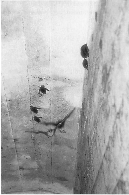
Abb. 9. Neben einer 4er-Gruppe Wasserfledermäuse, von denen 3 Ex. auf Körperkontakt und eins allein im von Decke und Wand gebildeten Winkel sitzen, haben sich 3 einzelne Tiere an der Betondecke niedergelassen, davon eins an der durch die Verschalung entstandenen Längsriefe; ein achtens, soeben eingeflogenes Ex. fliegt noch unter den sitzenden Individuen hin und her. Aufn.: LUTZ FITTERMANN
