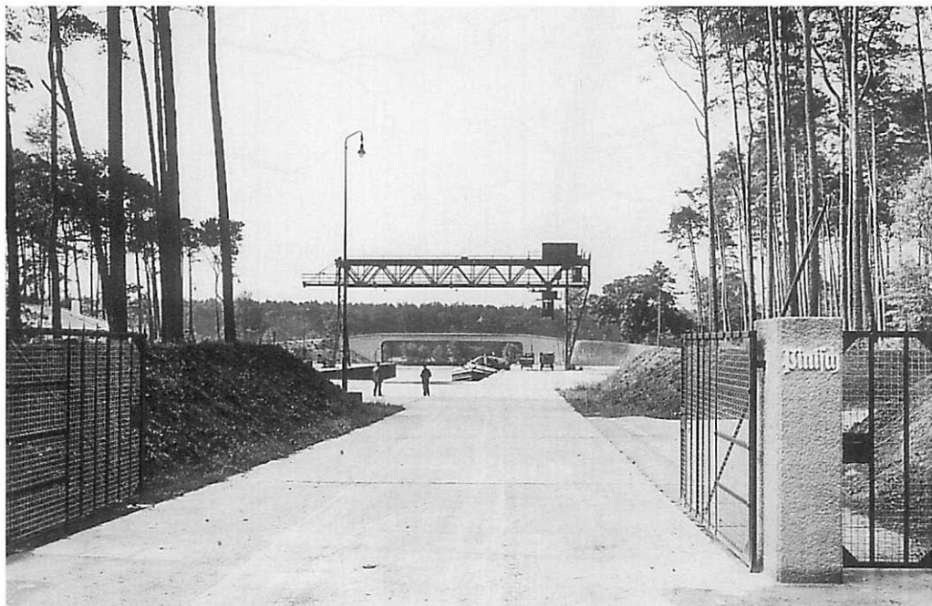
Abb. 2. Pintschhafen nach Fertigstellung im Jahre 1938 mit Fußgängerbrücke (Pintschbrücke) hinter dem Kran. Aufn.: Archiv Museum Fürstenwalde
