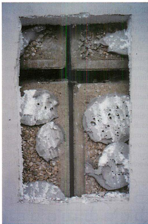
Abb. 7. Kreuz der Horizontal- und Vertikalfuge auf der Fassade mit aufgeschnittener Dämmung. Aufn.: JOACHIM STAPEL
