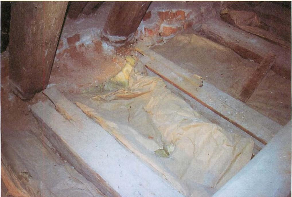
Abb. 1. Blick in den Fehlboden der Kirche Lauterbach nach dem Entfernen des Fußbodens. Das verpackte Isoliermaterial befindet sich noch zwischen den Deckenbalken. Aufn.: G. DINGER, 7.11.2000
