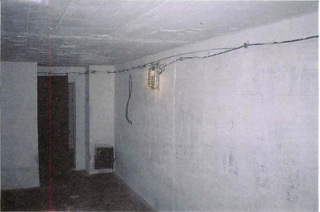
Abb. 4. Hangplatz(=spalten)armer Innenraum des unterirdischen Bunkers 120
