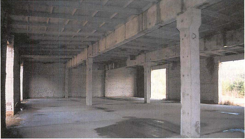
Abb. 9. Innenraum von Halle 146. Beachte die stabile Deckenkonstruktion aus Beton-Segmenten.
