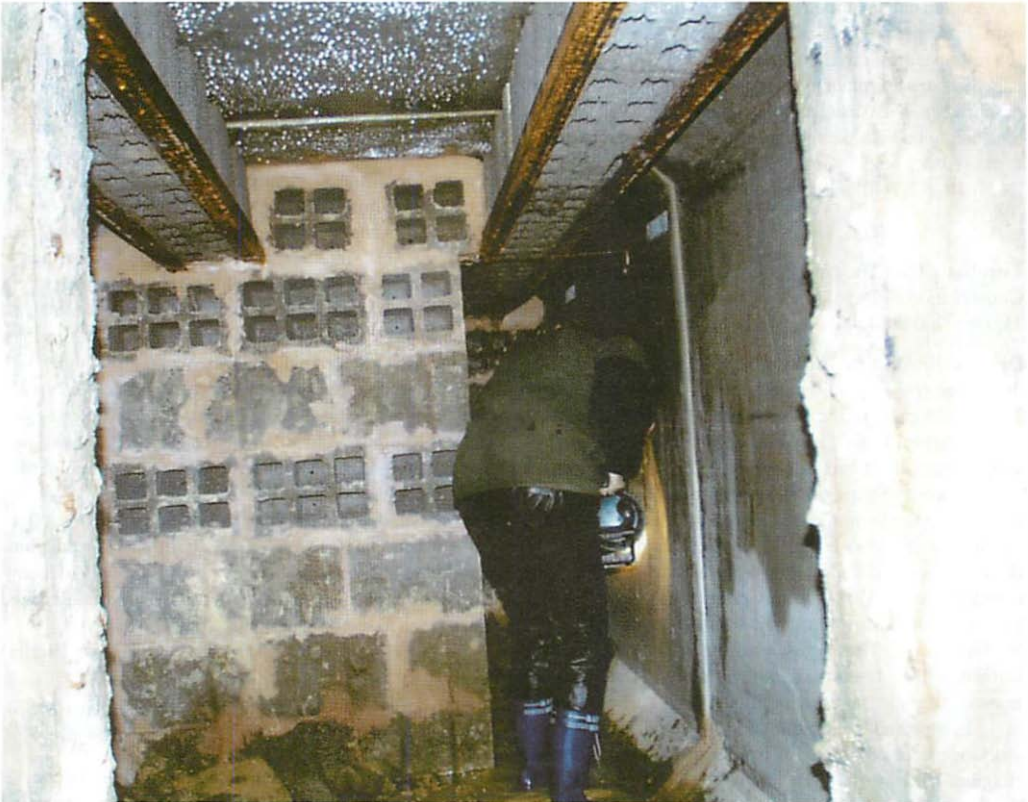
Abb. 3. Wände und Decke des künstlichen Stollens bei Sudheim sind mit Hohlblocksteinen eines Typs ausgestattet. Aufn.: THOMAS STEINBÜCHEL.
