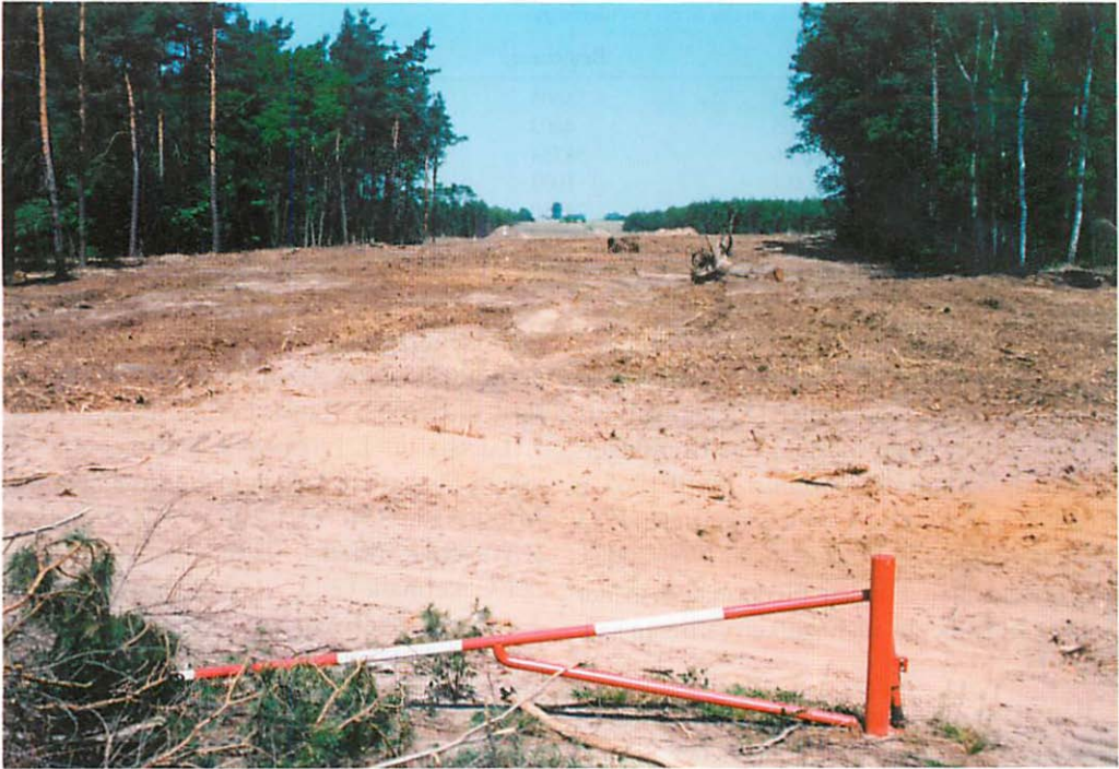
Abb. 2. Großzügige Beseitigung der Forstbestände und des Bodens im Fledermauskastenrevier für den Bau der Ortsumgehung Beeskow, 10.VI.2000. Aufn.: Dr. A. SCHMIDT
