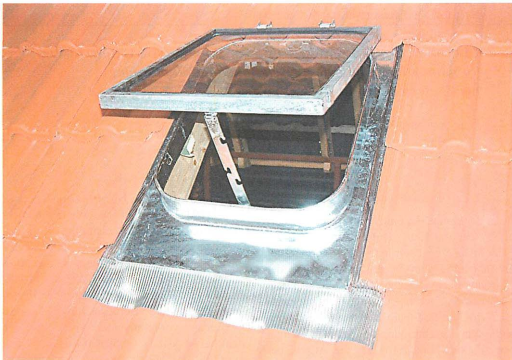
Abb. 4. Nachrüstoption. Austausch des ESG-Öberfensters gegen das der Ausführung 1 oder 2. Aufn.: JÖRG REIMANN.
