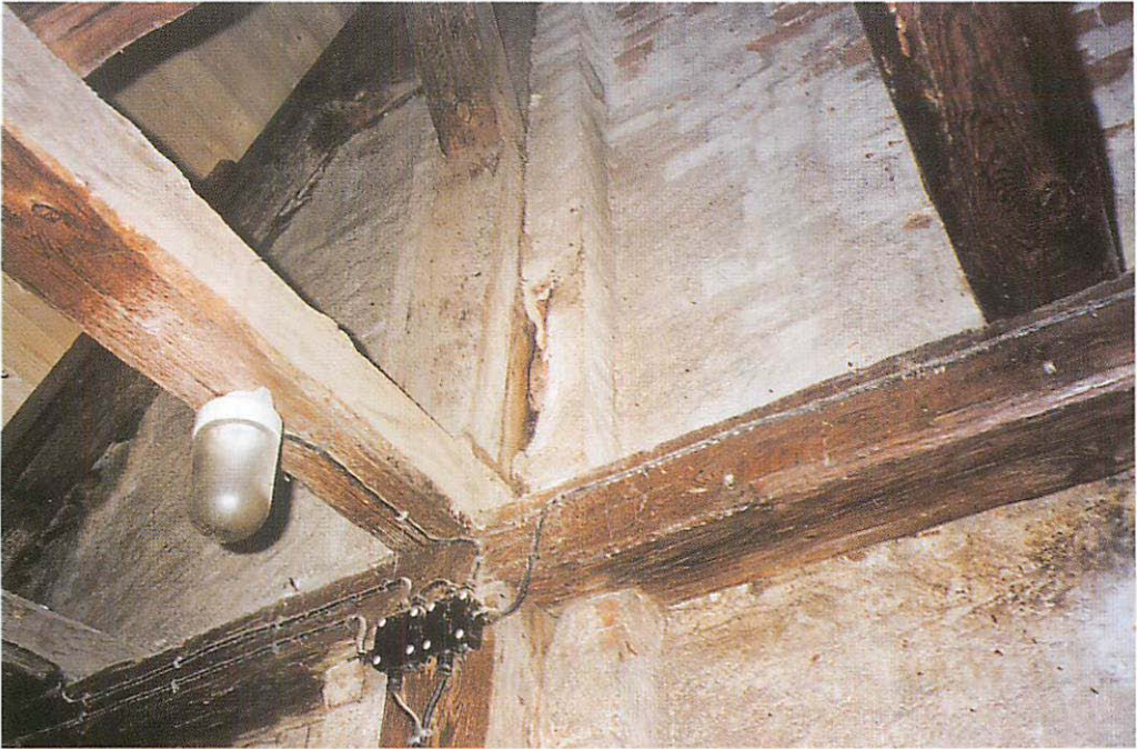
Abb. 5. Mauerspalte (Bildmitte) im Schloß Großmehlen, in die sich die Mausohren nach großen Störungen zurückzogen.
