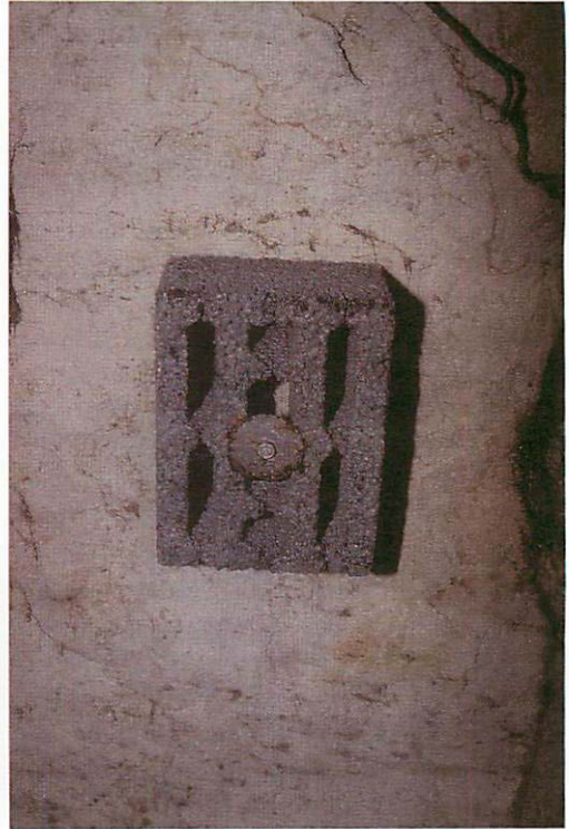
Abb. 2. Kleine Ergänzungssteine vom Format 3DF wurden aufgrund der niedrigen Höhe in Eingangsbereichen, insbesondere noch genutzter Keller, angebracht, um ein Anstoßen mit dem Kopf zu vermeiden. Wegen des geringen Gewichts ist dieser Typ auch gut für Winterquartiere aus weniger festem Deckenmaterial geeignet.
