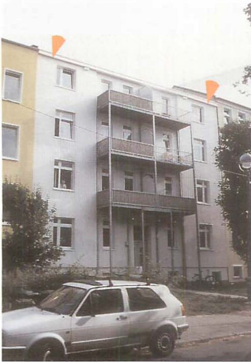
Abb. 5. Rostock, Patriotischer Weg 71 – straßenseitige Ansicht des Wohngebäudes. Die Pfeile weisen unterhalb des Traufkastens auf die zwei straßenseitigen Einflüge zum Fledermausquartier. Aufn.: U. HERMANNs
