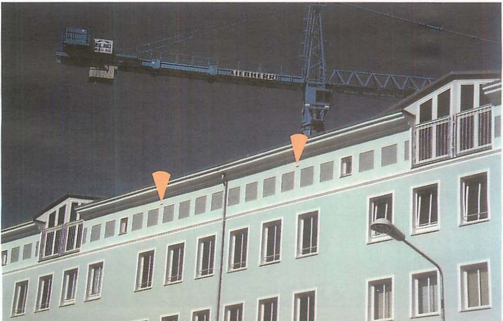
Abb. 13. Grubenstraße 35/36 – Teilansicht des Wohnhauses. Die Steine wurden im Bereich der ehemaligen Quartierorte eingefügt. Die Pfeile weisen auf zwei der sechs installierten Einbausteine. Aufn.: U. HERMANN'S
