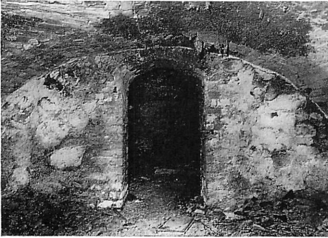
Abb. 1. Kellerräume des ehemaligen Forsthofes Kuhwinkel, Kr. Perleberg, die als Winterquartier für Braune Langohren ( Plecotus auritus ), Fransenfledermäuse ( Myotis nattereri ) und Mopsfledermäuse ( Barbastella barbastellus ) geeignet sind. Aufn.: U. BINNER
