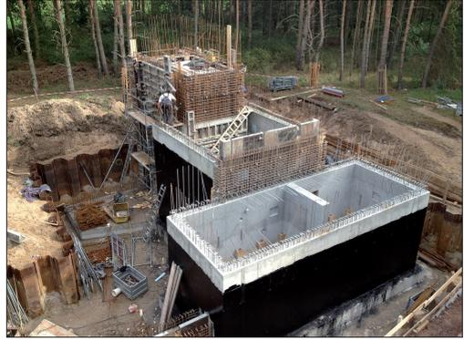
Abb. 8: Blick von der fertig gestellten Grabenkammer über die Hauptkammer zur für die Betonage vorbereitete Eingangskammer.
