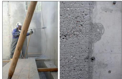
Abb. 4: Hochdruckwasserstrahlen der Innenwände.
