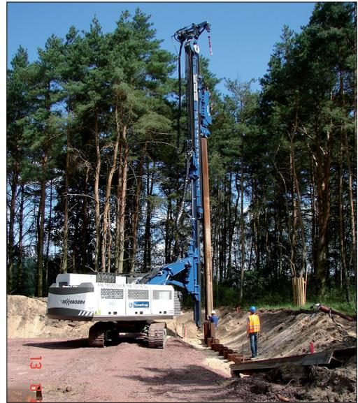
Abb. 3: Spundwandeinbau für Baugrube.
