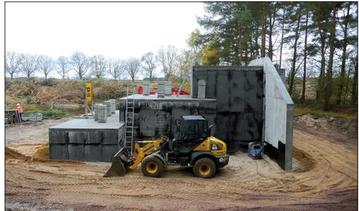
Abb. 10: Nach der Baugrubenverfüllung.
