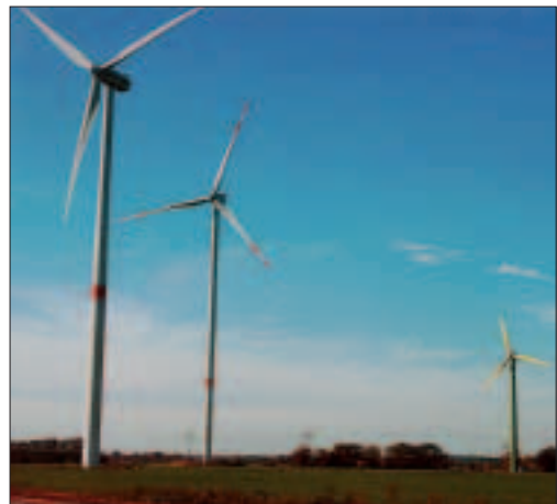
Abb. 1: Zur Zeit der 2013 durchgeführten Untersuchungen waren im Windpark Willmersdorf noch drei verschiedene Typen Windkraftanlagen vorhanden, zwei vom Hersteller Vestas, links eine ältere, kleinere Anlage (Typ V 80), in der Mitte eine der neu errichteten riesigen Anlagen (Typ V 112), rechts eine sehr kleine Anlage vom Hersteller Fuhrländer (Typ FL 1000). Alle Aufn.: Dr. J. HAENSEL
