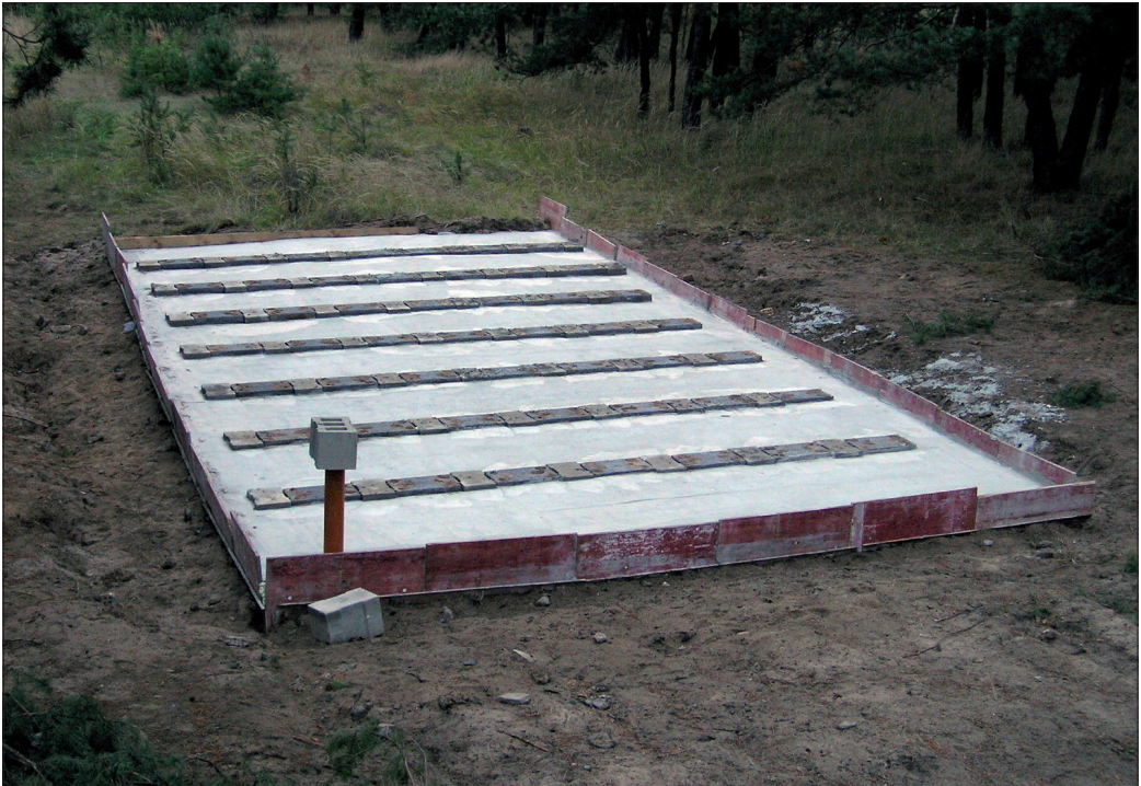
Abb. 5. Geschlossene Beton-Kellerdecke mit sieben Reihen eingebauter „Winklersteine“ und eingesetztem Belüftungsrohr. Aufn.: G. MAETZ.
