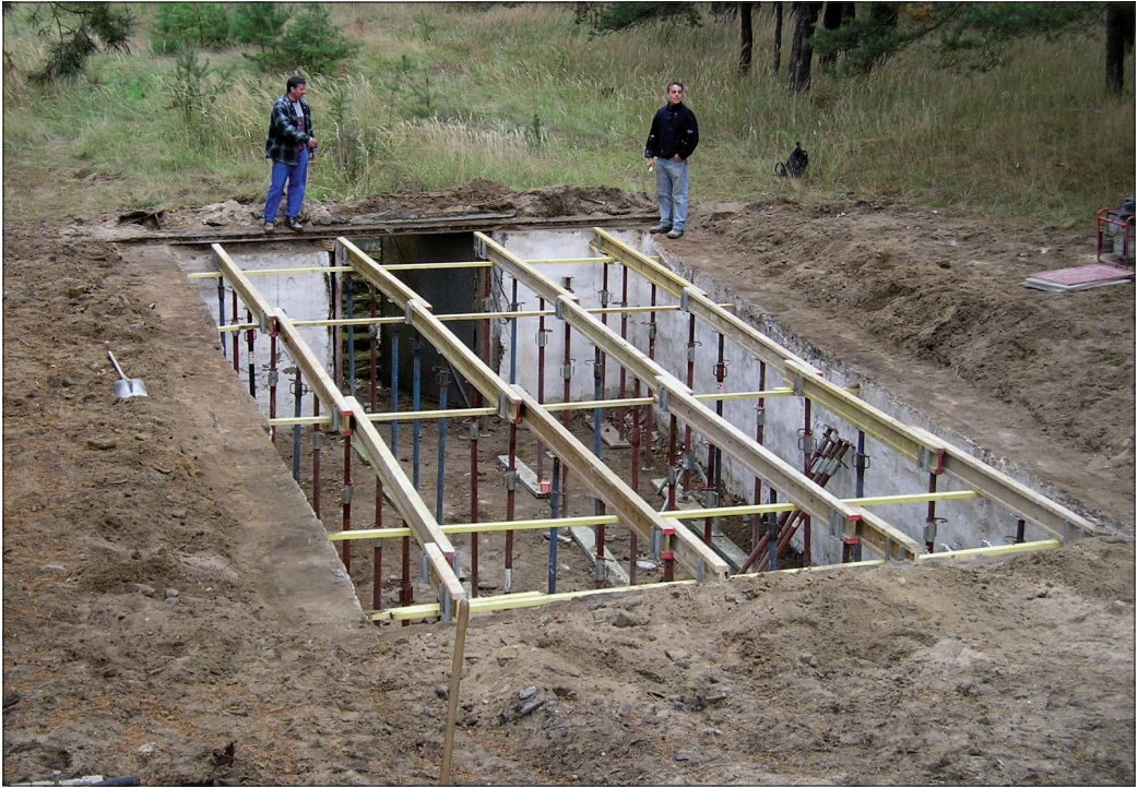
Abb. 4. Ehemaliger Kartoffelkeller mit geöffneter Decke und eingebrachten Stützen in Vorbereitung zum Aufsetzen der Deckenträger. Aufn.: G. MAETZ.
