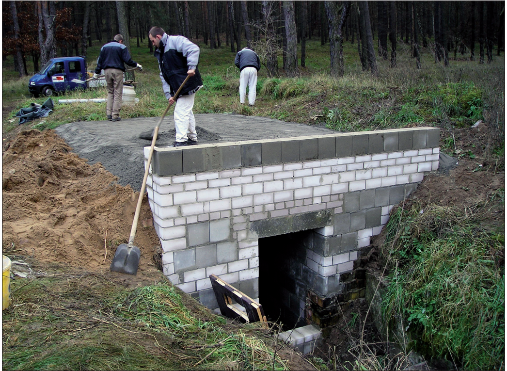
Abb. 8. Die geschlossene Kellerdecke am Keilberg wird überdeckt. Aufn.: G. MAETZ.
