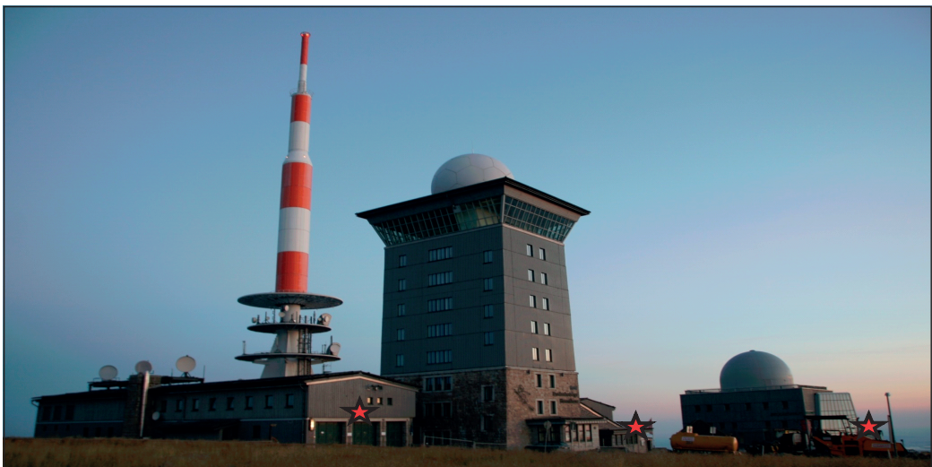
Abb. 9. Ostseiten der Brockengebäude mit Kotnachweisen (Sterne) von Pipistrellus pipistrellus , von links nach rechts: Garagen, Anbau Brockenhotel und Besucherzentrum des Nationalparks Harz.
