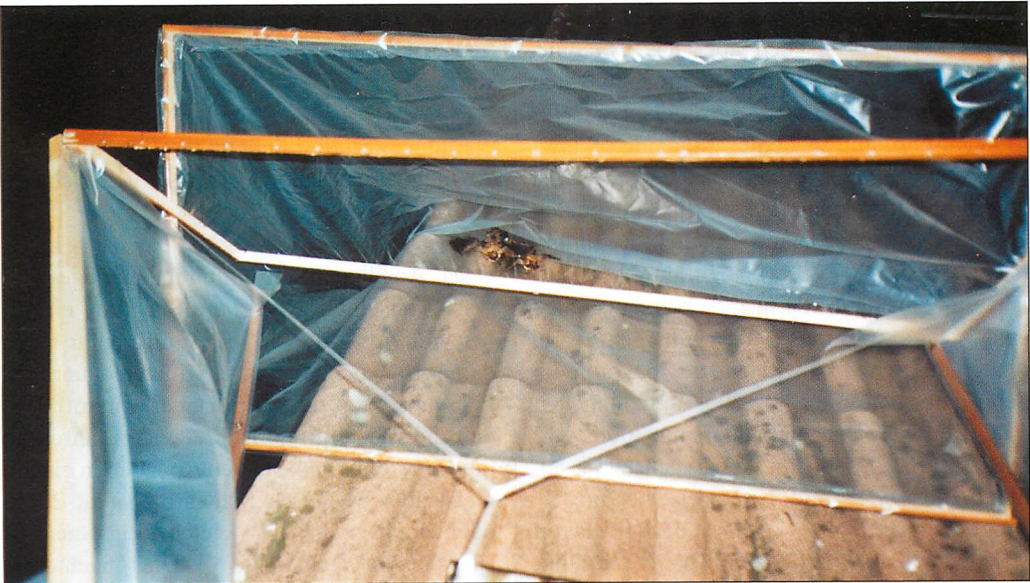
Abb. 6. Blick vom Schornsteinkopf in die Abfangeinrichtung („Harfe“). Die ersten herausgekommenen Zweifarbfledermäuse sind auf dem Plastikboden erkennbar; sie bewegen sich der Schräge nach auf die Öffnung der Rutsche zu, die über die Dachkante nach unten führt. Aufn.: LUTZ ITTERMANN
