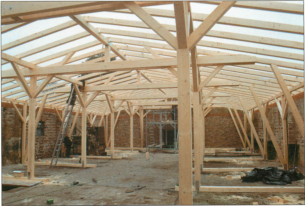
Abb. 8. Komplette Dachbodensanierung des Fledermausmuseums 2001-2002 über die gesamte Länge des ehemaligen Stallgebäudes. Aufn.: U. GRÜTZMACHER
