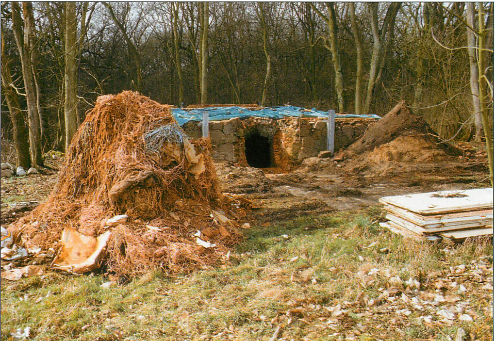
Abb. 3. Beginn der Aufbauarbeiten am Internationalen Fledermausmuseum: Entrümpelung des Eiskellers (Einstieg im Hintergrund), vor dem sich der herausgeholte wilde Müll türmt; links ein überwiegend aus altem Bindegarn bestehender „Berg“. Zustand im Jahr 2000. Aufn.: U. GRÜTZMACHER
