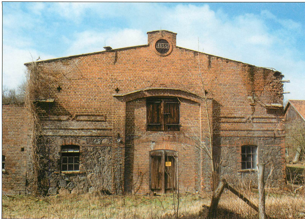
Abb. 9. Östliche Giebelseite – mit dem ganz oben verewigten Jahr der Gründung des Bauwerks (1855) – vor der Sanierung (2000). Aufn.: U. GRÜTZMACHER
