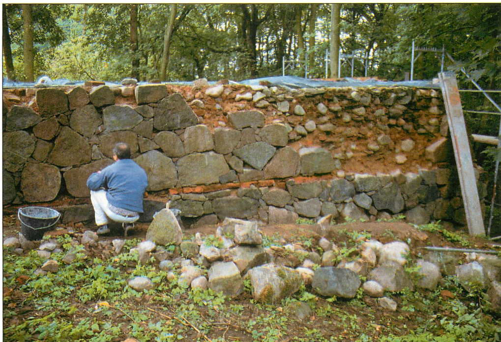
Abb. 4. Sanierung des Feldstein-Mauerwerks am Eiskeller (2000). Aufn.: U. GRÜTZMACHER
