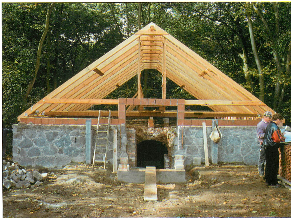
Abb. 5. Aufbau des Eiskeller-Dachstuhls (2001). Aufn.: U. GRÜTZMACHER
