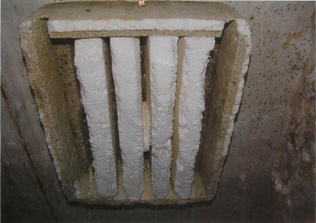
Abb. 4. Styropor-Kasten mit unterschiedlich breiten Spalten in der großen Bahnunterführung Görlsdorf.
