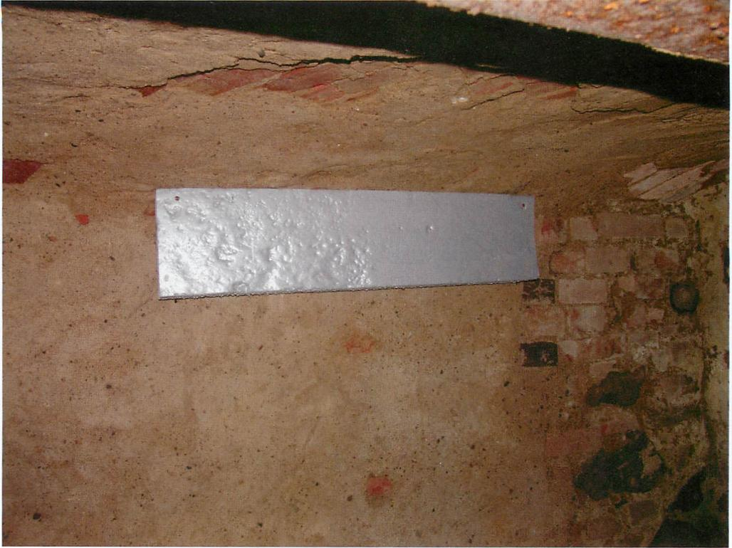
Abb. 6. An der Wand angebrachter, durch Keile auf Abstand gehaltener Styropor-Streifen im Keller Blei.
