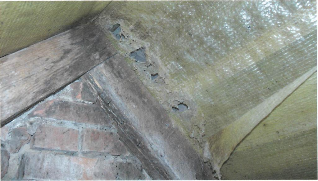
Abb. 6. Gatow. Von Mausohren beschädigte Unterspannfolie im Dachfirstbereich. Aufn.: HEINO HAUF
