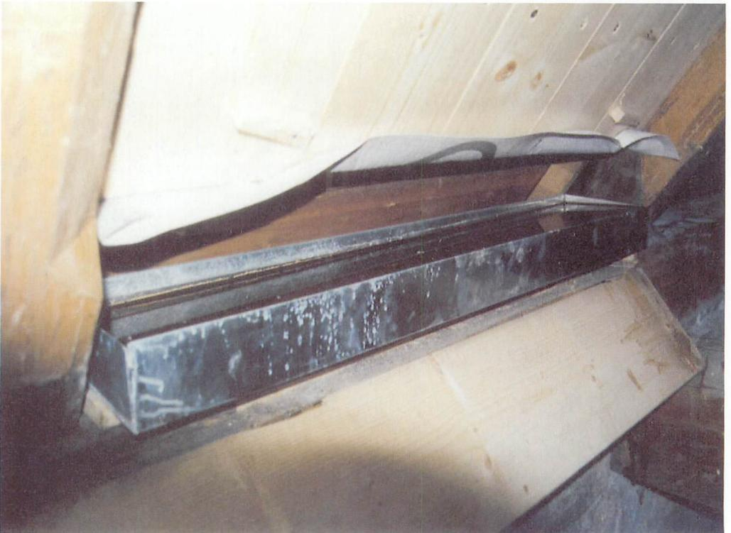
Abb. 13. Pfarrkirche Gehofen; geöffnete Kotrinne unter dem Dach. Aufn.: A. DANZ
